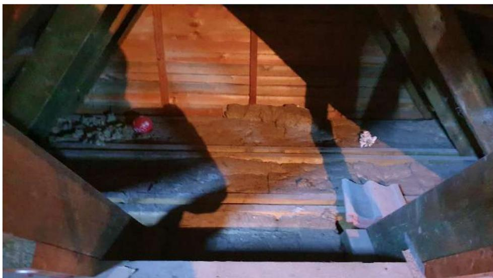
Abbildung 27: Dämmung oberste Geschossdecke Ärztehaus
