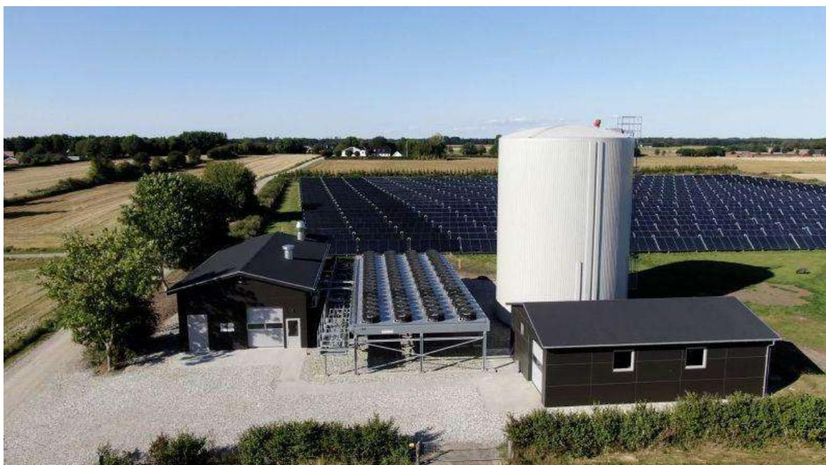
Abbildung 32: Heizzentrale eines Wärmepumpe basierten Wärmenetzes (Aalborg CSP, 2022)
